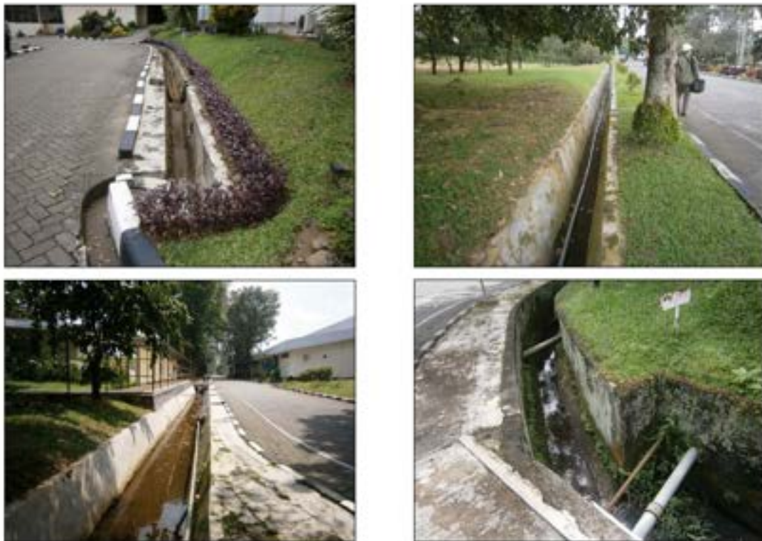
Gambar 3.5. Kondisi saluran drainase di lokasi studi.
